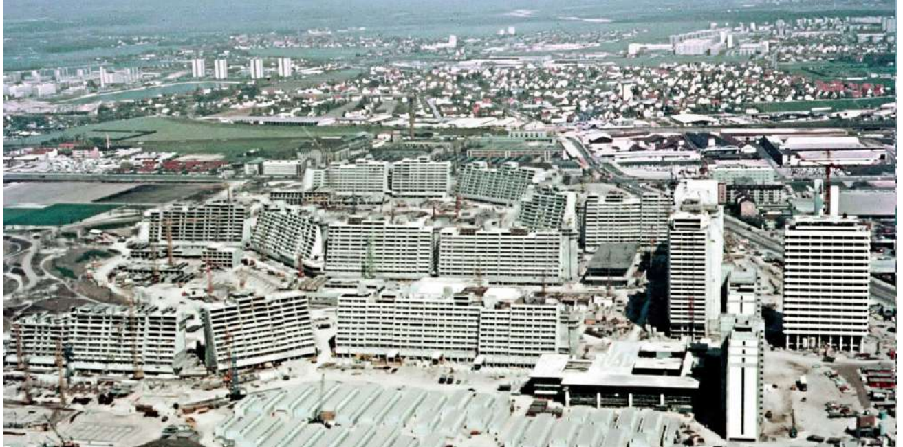
Das Olympiazentrum im Bau 1971
