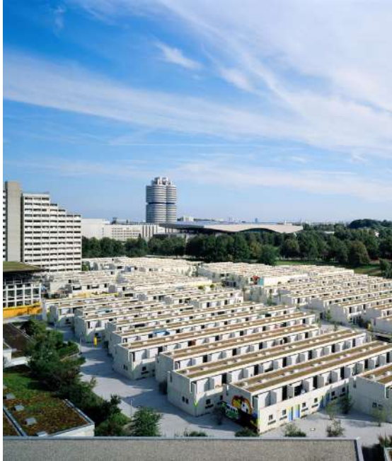
Die Bungalow Reihen nach dem Neubau
